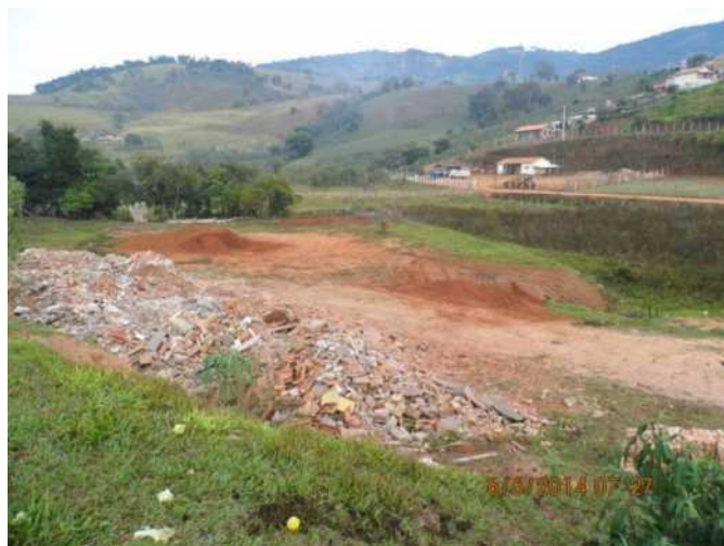
FIGURA 26 – Local de Disposição de Resíduos de Construção Civil.
