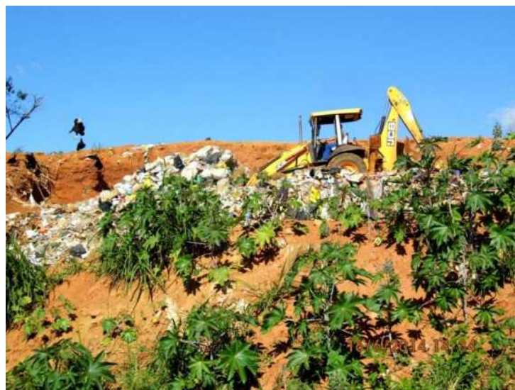
FIGURA 28 – Vista geral da disposição final dos resíduos sólidos.
